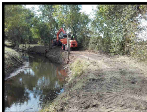
Déblais à partir des berges
