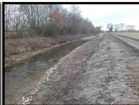
Retalutage et rétrécissement de la section d'écoulement
