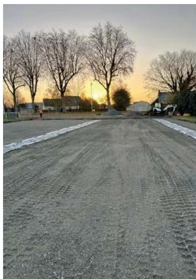
De nouvelles pratiques seront possibles sur ce terrain dont le revêtement est en matière synthétique avec un remplissage en matière naturelle en rafle de maïs, solution plus économique et écologique. Cela correspond à l'axe de l'épi de maïs sur lequel sont implantés les grains. Broyée et concassée, cette rafle produit de très petits granulés répandus à raison de 3 kg/m<sup>2</sup>.
